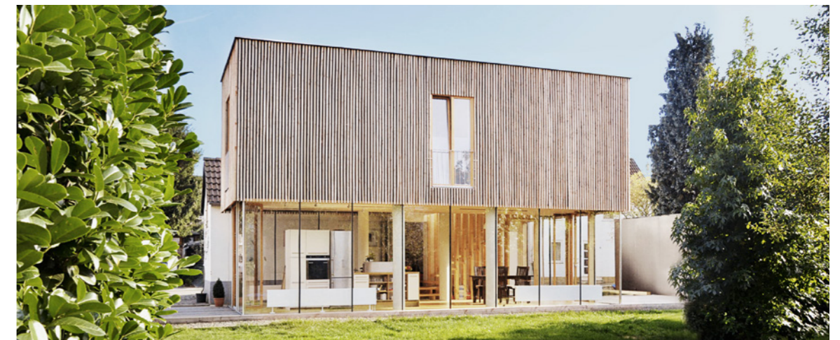
Aufstockung; Holzhüter Architektur, Aachen
